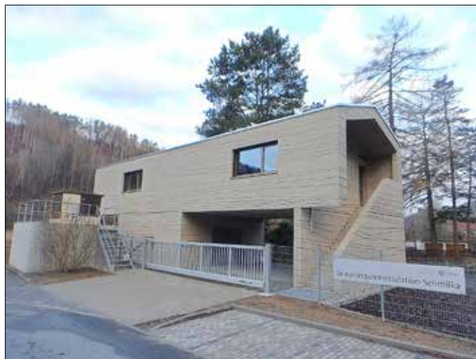
Ansicht Gewässergütemessstation Schmilka
