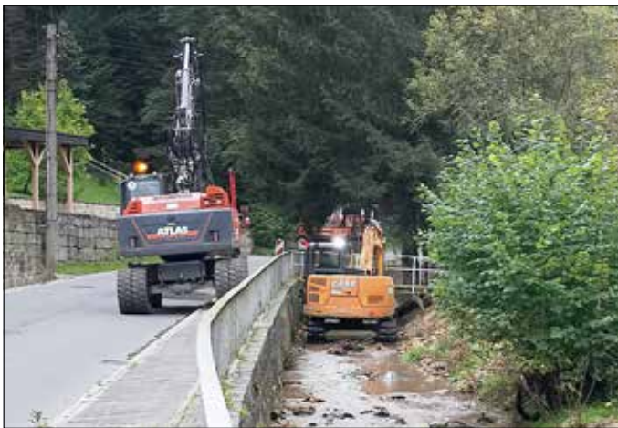
Baggerarbeiten im Krippenbach
